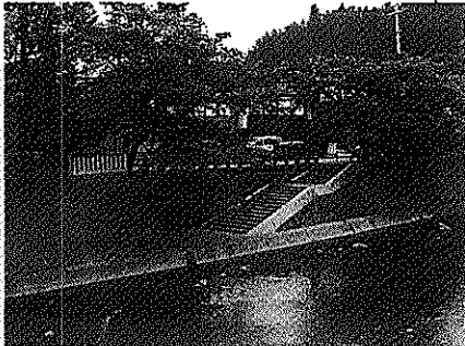
後橋上流の石張河岸 高山らしい風情を感じる空間である
