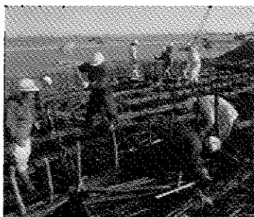
写真-13 粗朶沈床組立状況 7)
