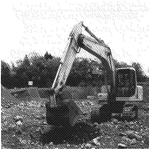
写真-9 スケルトンバケットによる透かし礫層造成
