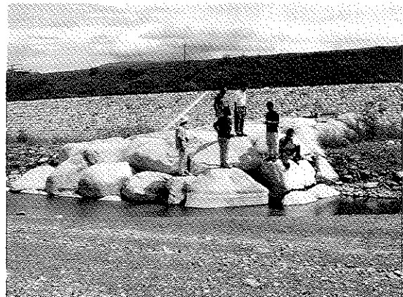
写真-1 巨石水制工の施工実績(犀川73.5km 右岸)
