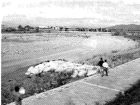
写真-1 巨石水制工の施工実績(犀川73.5km 右岸)
