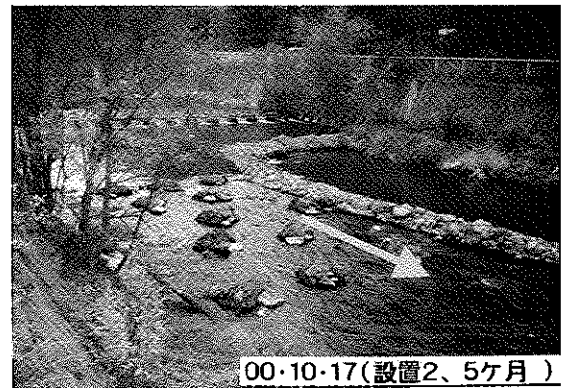
写真-4 実験水路施工後の状況(浮石区間)
