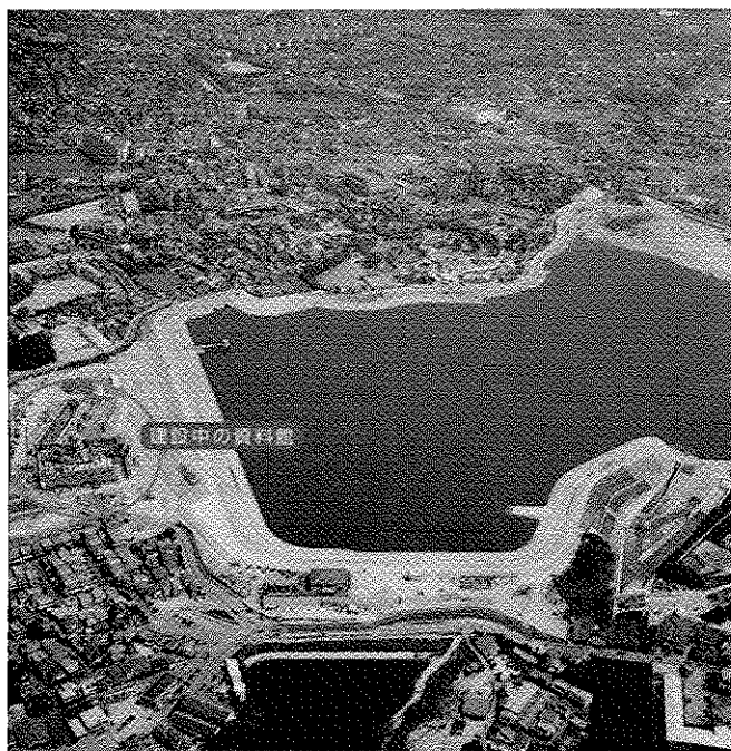
写真－3 狭山池の外観
