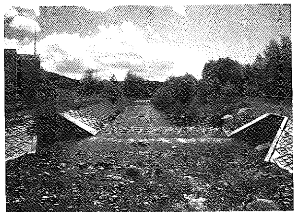
写真－3 改修済区間
