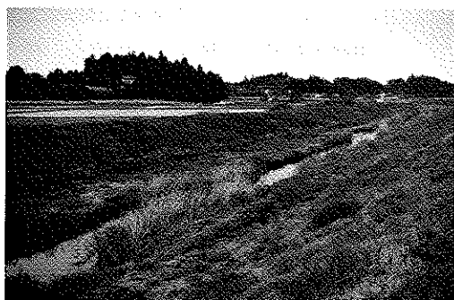
図-6 ウォッシュ・ロード堆積タイプの低水路 (茨城県園部川)
