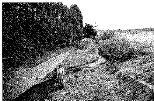
図－９ 砂礫堆積タイプ(砂州形成型)の低水路 (茨城県川又川)
