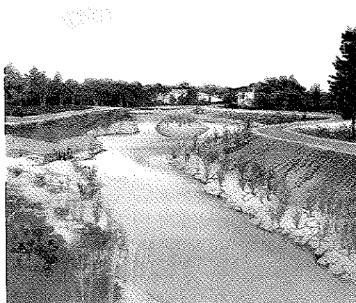
フラクタルにより水際線と柳枝工を配置した護岸
