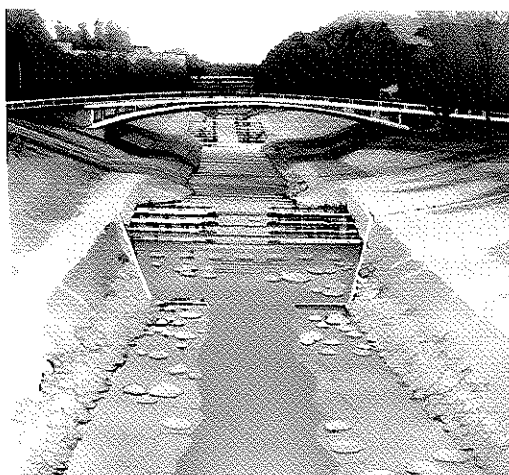
フラクタルにより河床の石と水際線を配置した落差工
