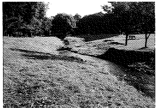
写真－ 4 施工後1年半
