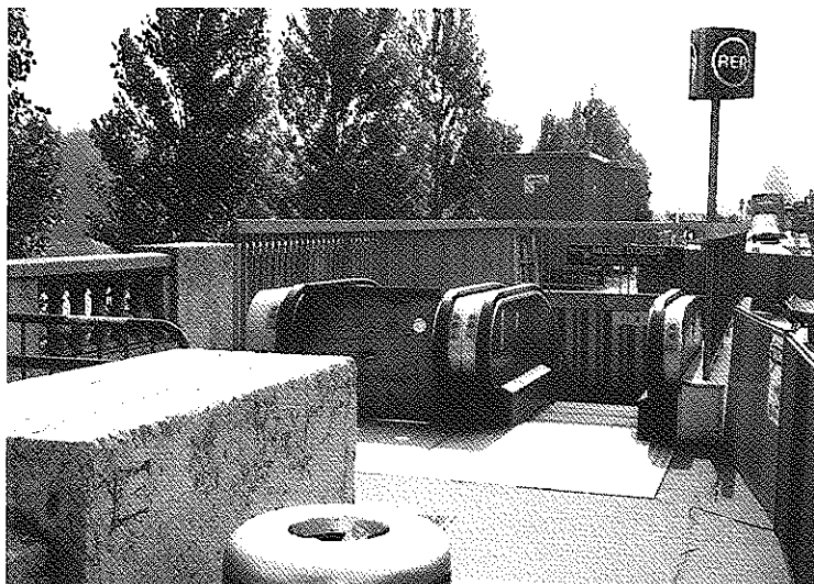
写真-5 ソルフェリノ歩道上流、左岸、RER入り口
