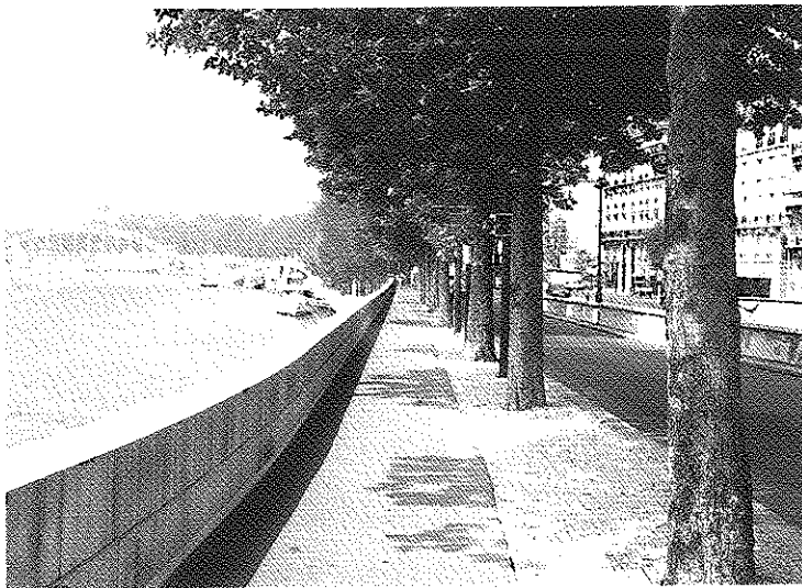
写真-8 アルス橋下流、右岸
