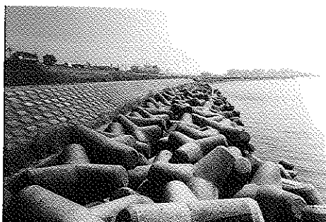
水際部に変化を与える根固め工も異形ブロックを乱雑に捨てるだけでは逆効果となる
