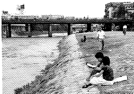
肩部をラウンディングするとともに植生回復の折り返し工として柔らかく仕上げる
