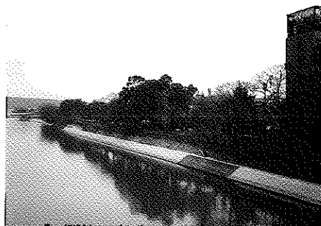
途中に階段を1箇所組むだけで単調さはかなり緩和することができる
