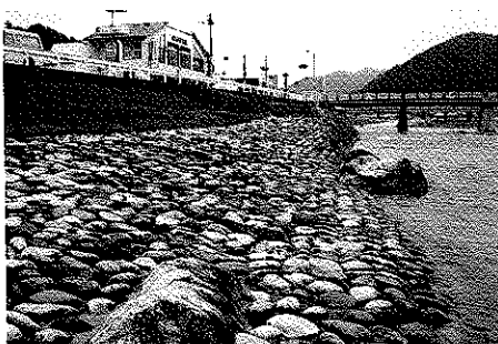
すりつけ区間を十分にとり漸次的に形状を変化させることで境界部のおさまりは良くなる
