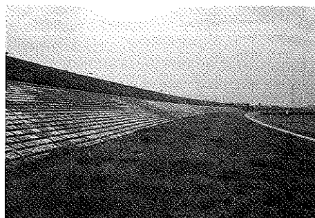
小段部だけを芝張りとするだけで高水護岸の硬い印象を随分とやわらげることができる
