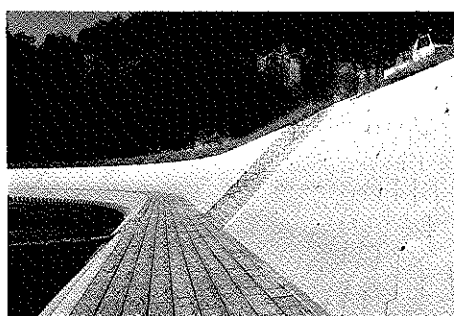
直高が大きい場合には急勾配にして下部に小段を設ける方が全体的には好ましい景観になる
