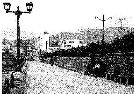
小鋪石の舗装の小段。切り欠き部にベンチを設け広い小段全体を快適な空間に仕上げている
