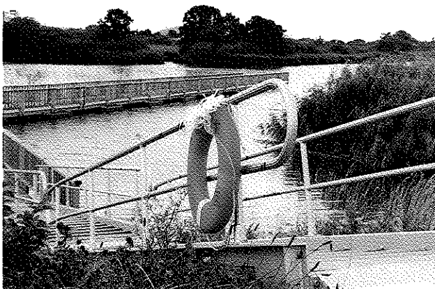
ロープ付浮輪設置事例
