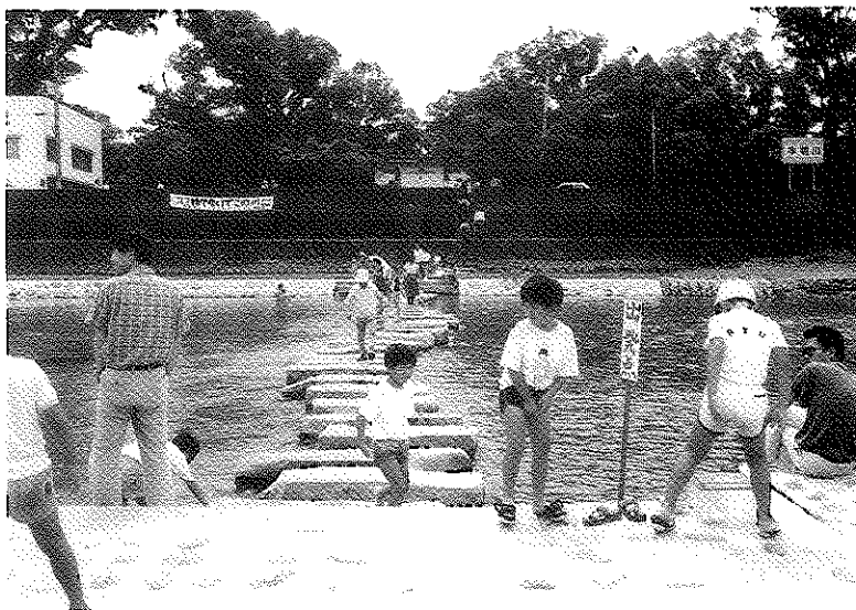
すれ違いが可能な幅を確保してある飛石の例（長崎県、本明川）
