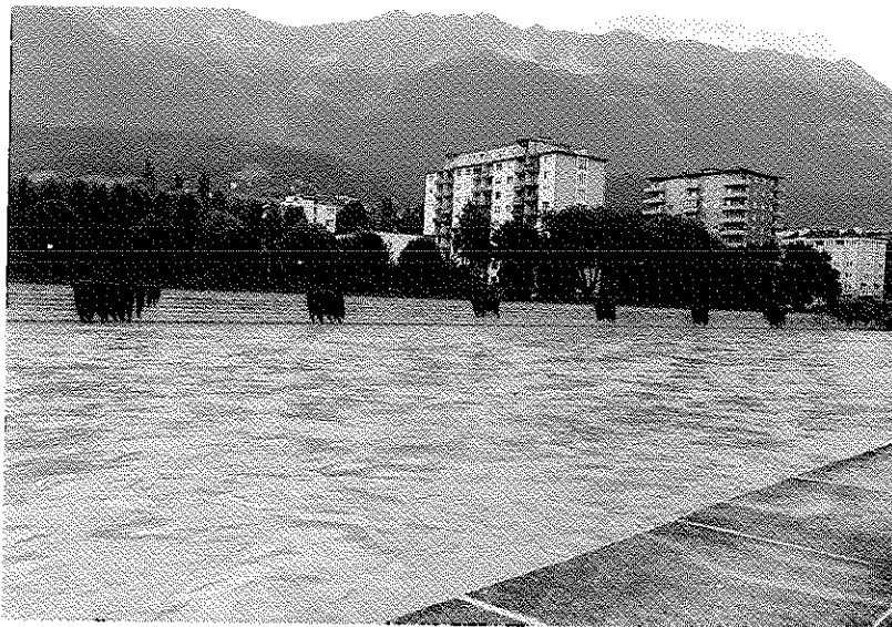
・イン川左岸の護岸 (ほぼ等間隔状に緑で覆うことによりコンクリートの 与える印象を和らげている。)
