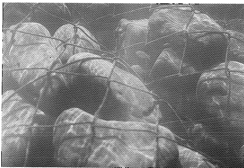
写真－６ 蛇かご工の水中状況
