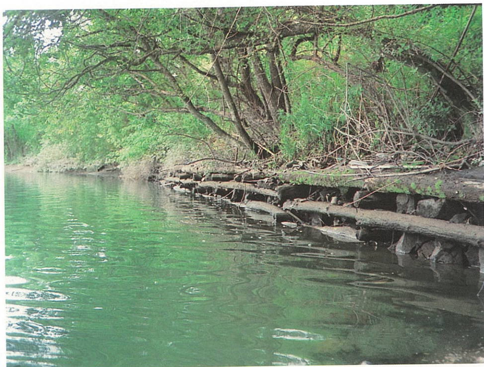
伝統的河川工法の例・木工沈床
