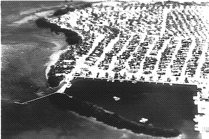
写真二 キーウエスト方面には珊瑚の島をリゾート基地として整備している所が多く、掘込み型のマリーナが多く見られる。
