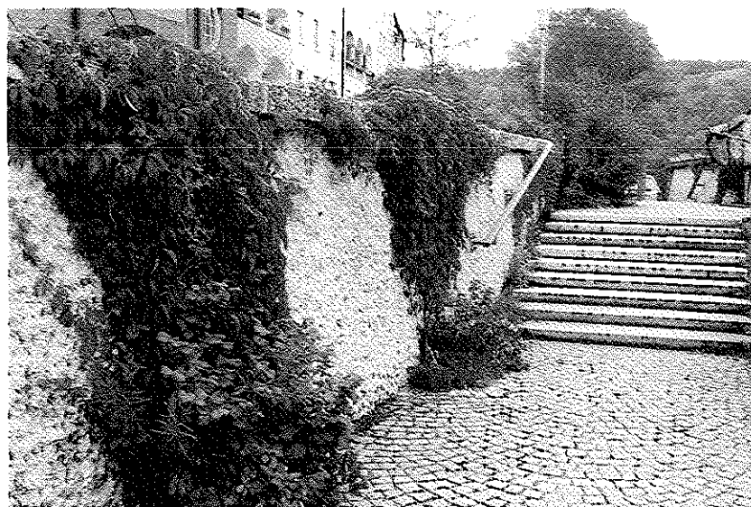
写真－８ パラペット堤防はコンクリートをはつってやわらかみのあるテクスチャーとし、 つたを垂らしてシャープな線をぼかしている (西ドイツ・ヴァッサーブルグ・イン川)
