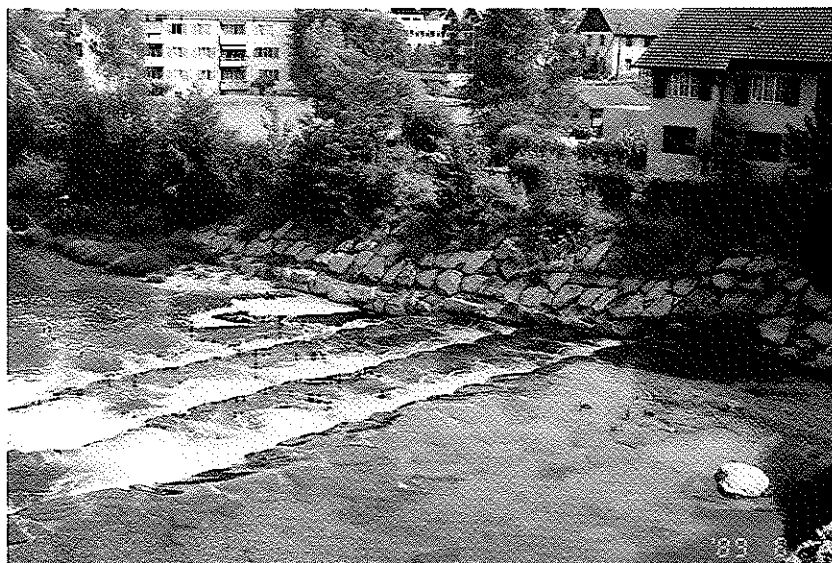
写真－７ 石積みの上に草を茂らせてシャープな線をぼかし、やわらかみを出している (スイス・ロアバス・テス川)
