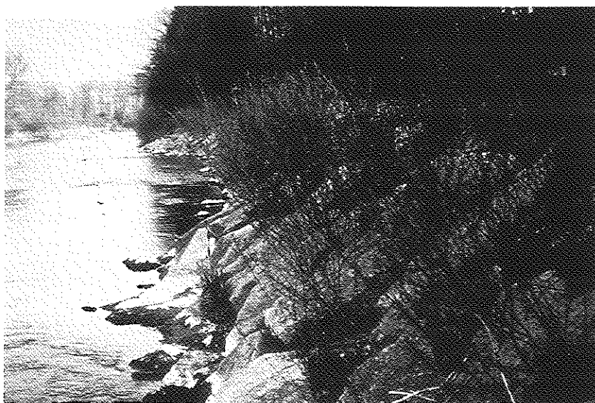
写真-13 柳枝工により生態系を保全しつつ川岸をまもる (スイス・チューリッヒ州・テス川)
