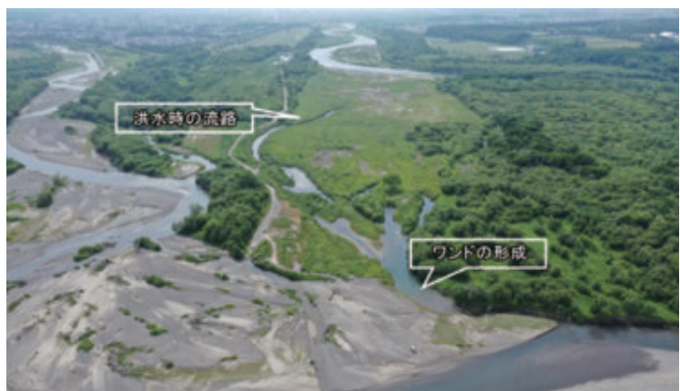
写真1 北海道十勝川における河道掘削による多様な生物生息場環境の造成(北海道開発局提供)
