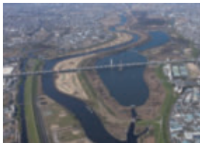
洪水調節施設の整備
