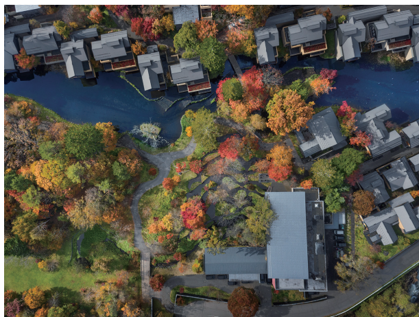
星のや軽井沢の空中写真。 手前の大きな屋根が「集いの館」
