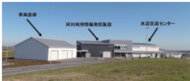
写真-1 防災拠点整備
