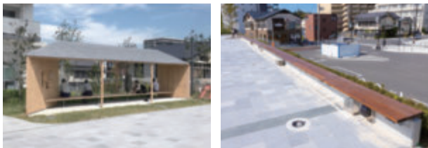
写真－7 各種施設（東屋、ベンチ）
