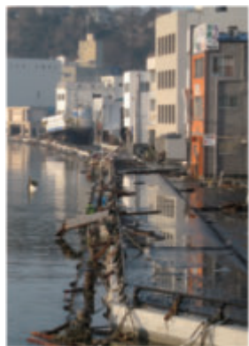
写真-1 被災直後の石巻市中央地区
