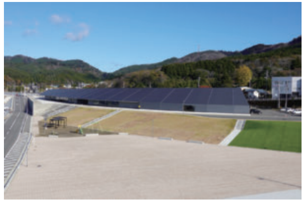
写真1 石巻市鮎川地区：海岸堤防（直壁型特殊堤・傾斜堤）と観光交流施設等を一体的にデザインした事例
