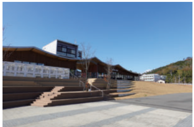
写真2 気仙沼市内湾地区：海岸堤防（直壁型特殊堤）と建築を一体化した事例
