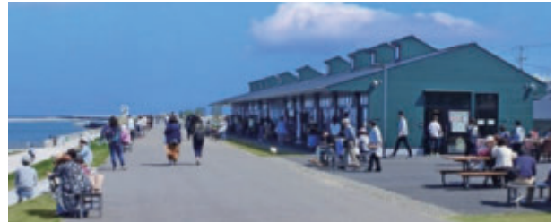
堤防側帯上の商業施設（かわまちてらす閑上）の利用状況
