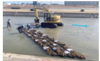
写真7 バープ工施工状況
