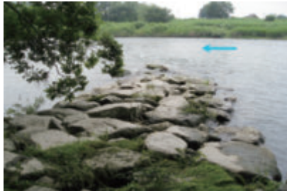
写真1 矢作川の水制工
