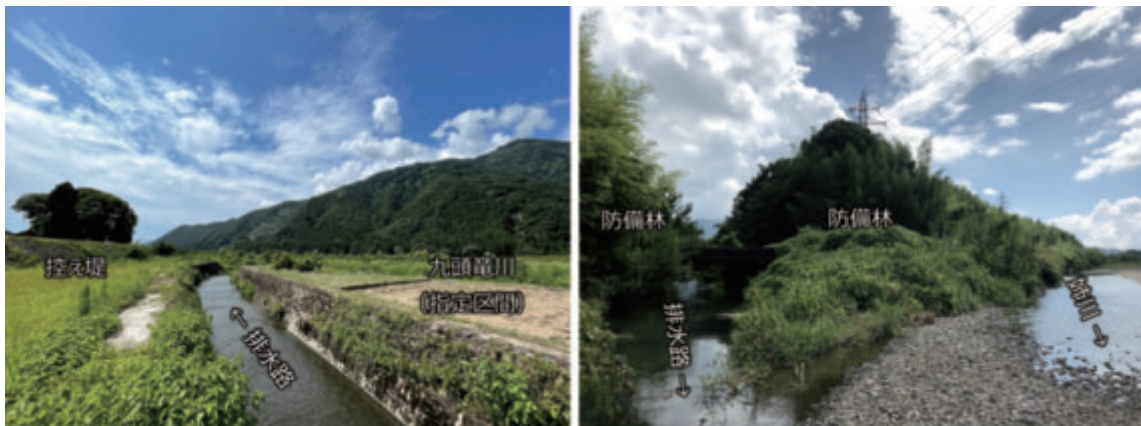
写真1 霞堤遊水地から本川に流れる排水路(左:九頭竜川、右:姉川)
