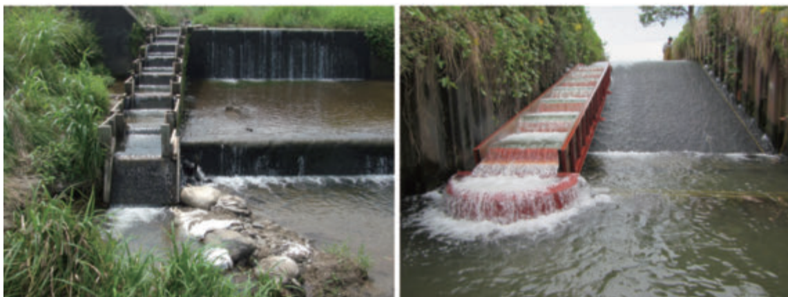
写真2 落差を解消した手作り魚道(左:喜撰川、右:中ノ池川) 写真提供:滋賀県流域政策局(左)、滋賀県立琵琶湖環境科学研究センター(右)
