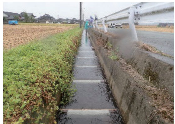
図10 水路に導入した流速低減策
