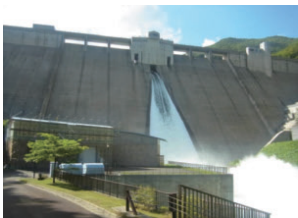
写真2 ダムからの人工放流（2014年6月24日）
