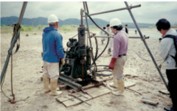
木津川神谷地区での伏流水(地下水)の観測井の掘削工事
