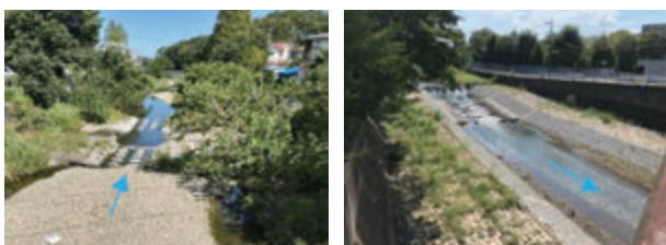
図-1 未改修区間の現況 図-2 改修済み区間の現況
