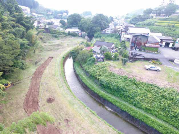
着工前の神代川（平成 28 年 10 月）
