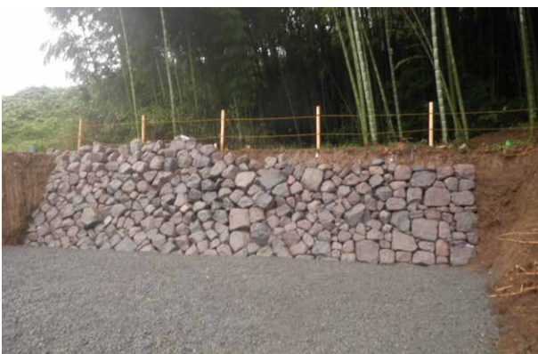
試験積み（写真左側 乱積・写真右側 あのを積み）
