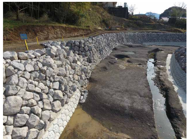
石積み完成写真（下部コンクリートブロックは計画河床高の為、河床工事後見えなくなる）
