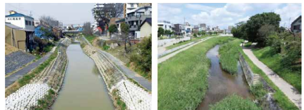
写真-2 伊賀川における復旧状況
