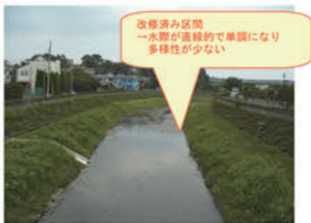
写真1 改修済み区間
