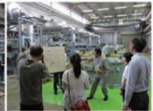
辰巳排水機場
