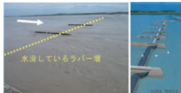
図4 高屏溪攔河堰（増水時と平常時）
