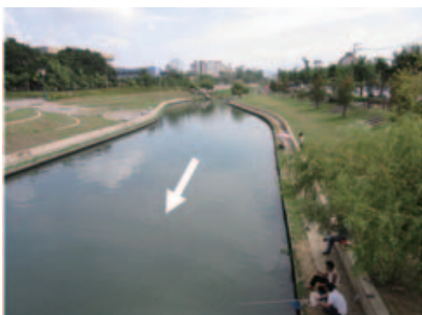
図7 早溪康橋（上流を望む、左側奥が中興大学）
