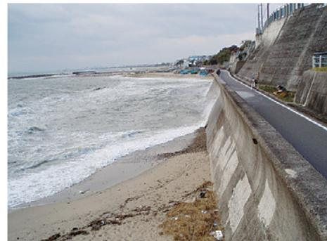
写真-3 砂浜の有無による越波状況の違い
