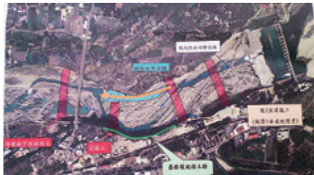
写真4 石岡堰直下流の河床低下対策
