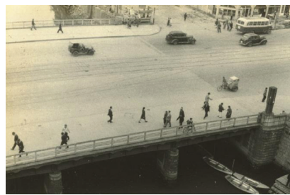
埋められる直前の三原橋（京橋図書館蔵）
