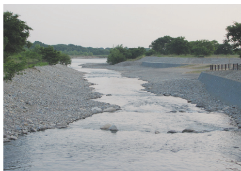
写真4 自然石を活用した落差工と 護岸前面の覆土工 (各務原市 北派川)
