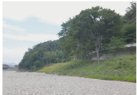
写真1 河畔林の保全に工夫をした護岸工 (岐阜市 長良川)
