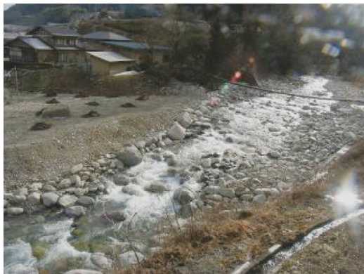
写真3 巨石によるステップ&プールの整備 (下呂市 山之口川)
