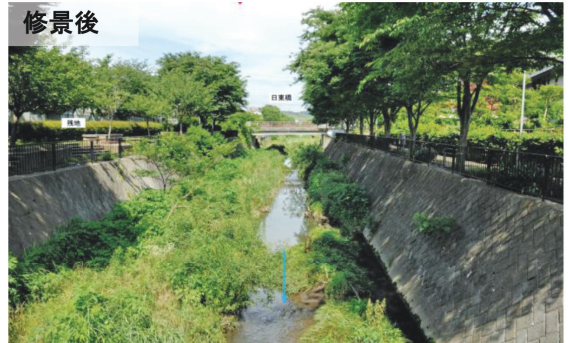
写真四 4 護岸天端部に植樹し15年経った事例（いたち川：神奈川県）
