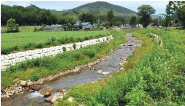
写真一 1 現地の発生材で寄せ石をして自然な水際を形成している事例（元町川：岩手県）
