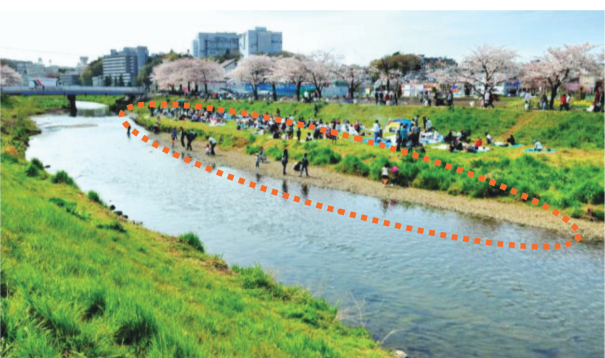
写真三 3 河床幅を広く設定しているため砂礫が内岸側に堆積し自然な洲が形成されている事例（黒目川：埼玉県）
