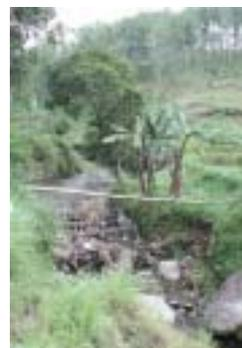
写真7 集落からの排水対策 (流入河川における自然素材を用いたスクリーンの設置) (2011年1月)
