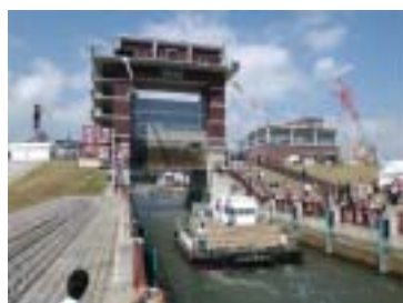
荒川ロックゲート (荒川)
