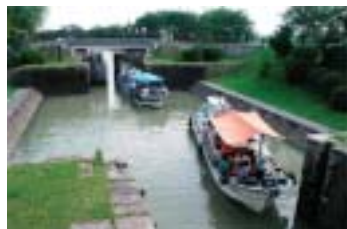
船頭平閘門 (木曾川)
