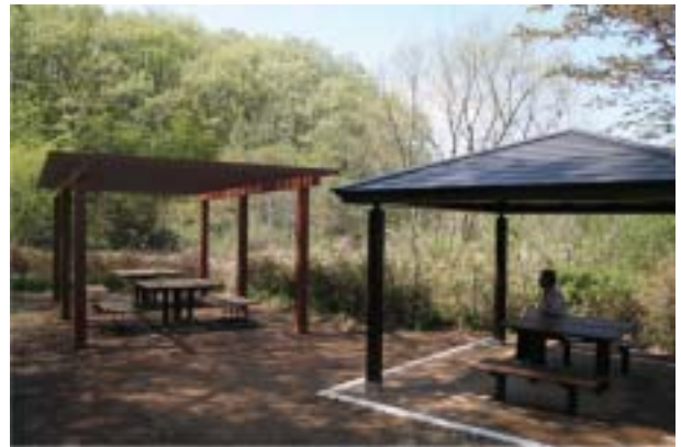
北本市自然遊歩道休憩舎
