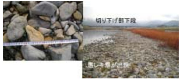
図-14 H21年度施工箇所(H22：施工後1年目撮影)
