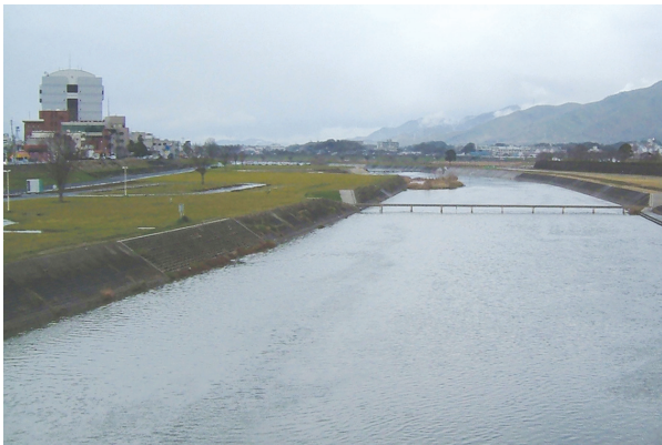
写真－2 改修前の遠賀川
