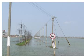
写真-2 地盤沈下箇所の浸水状況
