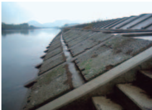
法枠中詰めポーラスブロック完成時（H12/11）
