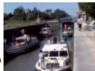
写真—12 ヌリギエ閘門 水位差 4.0m セルフでの操作
