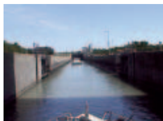
写真—10 サン・ジル閘門 水位差 3.0m 195m×12m
